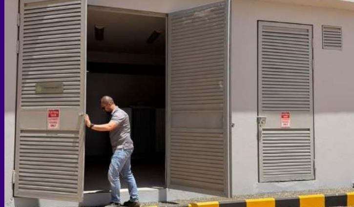
باب الغرفة وشيش التهوية ROOM DOOR AND VENTILATION LOUVRES
