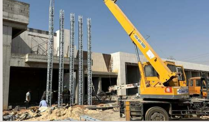
رفع القطاعات بالرافعة CRANING THE SECTIONS INTO PLACE
