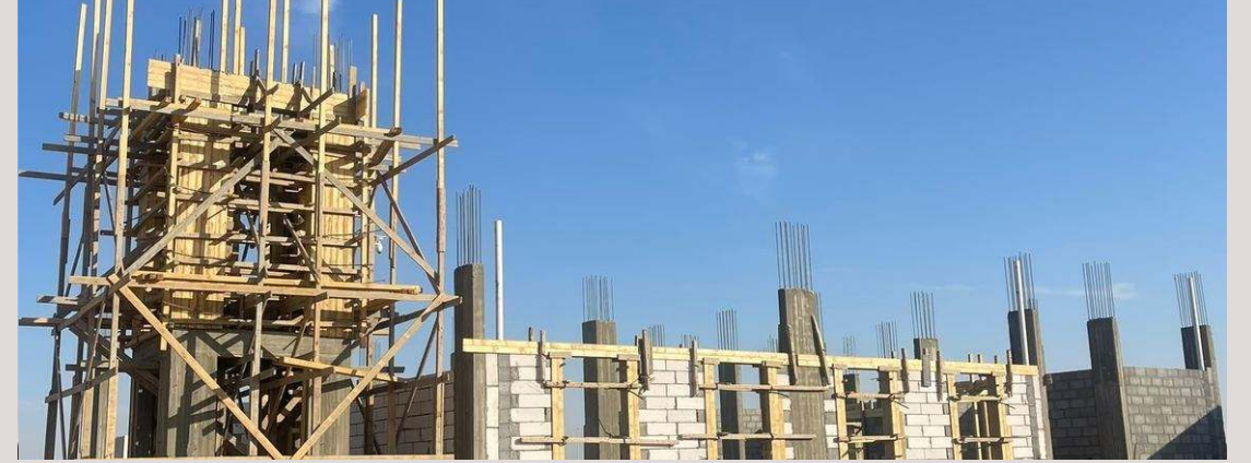
بيت الدرج وجدران البلوك STAIR CORE AND BLOCKWORK
