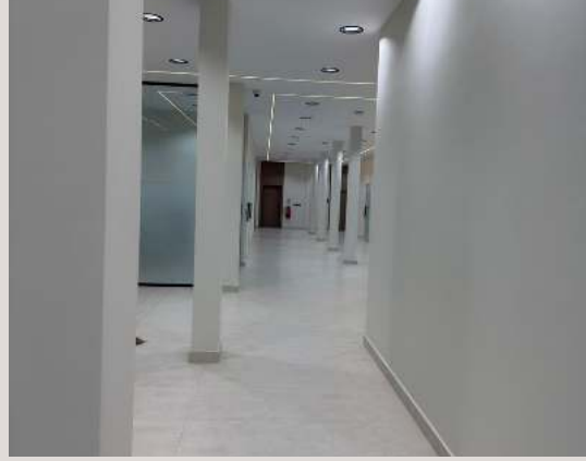
ممر المكاتب بأرضية بورسلين OFFICE CORRIDOR — PORCELAIN FLOORING
