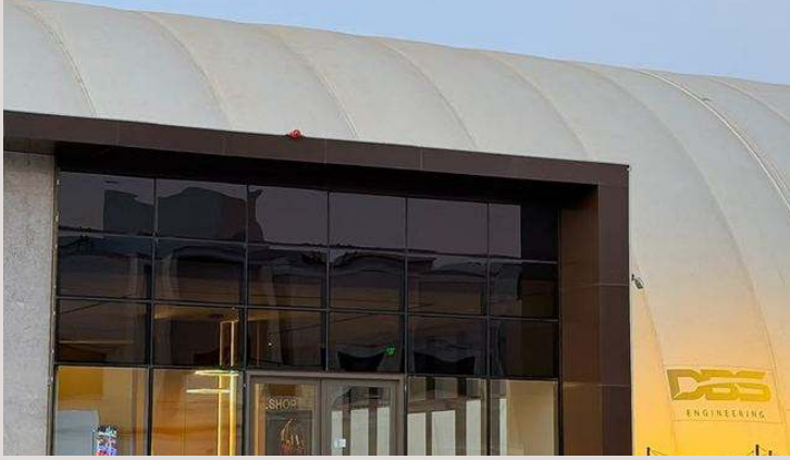
الواجهة الزجاجية بإطارات ألنيوم GLAZED FAÇADE IN ALUMINIUM FRAMING
