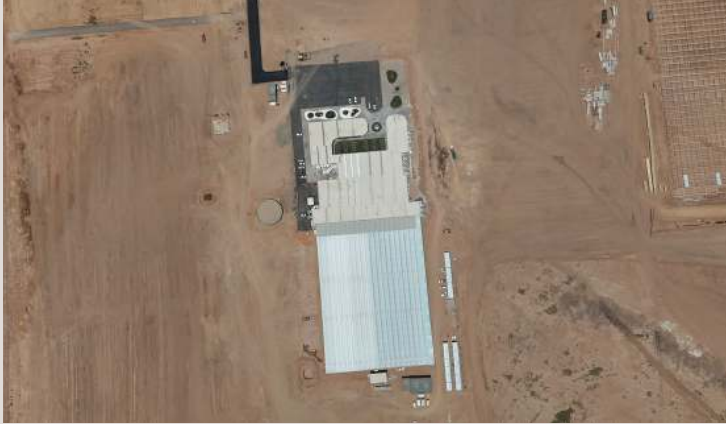
لقطة جوية عمودية — مبنى الخدمات VERTICAL AERIAL — SERVICE BLOCK
