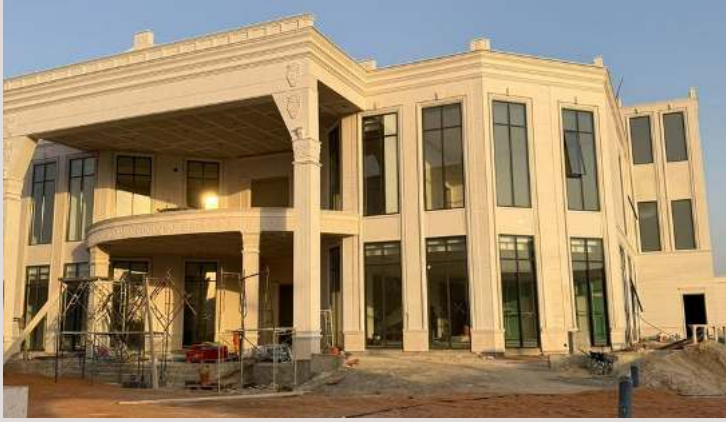
الواجهة الأمامية أثناء التنفيذ FRONT ELEVATION UNDER CONSTRUCTION
