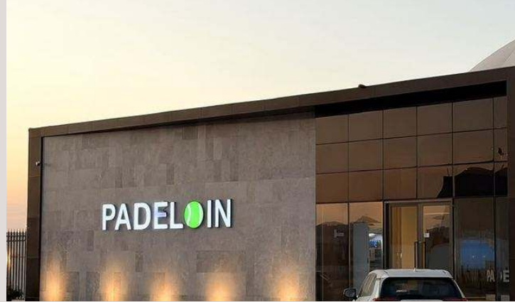
الواجهة الحجرية بلوحة مضاءة STONE FRONTAGE WITH ILLUMINATED SIGN
