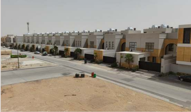
صف الفلل ومداخلها
