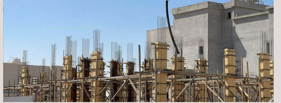
قوالب الأعمدة وضخ الخرسانة COLUMN FORMWORK AND CONCRETE PUMPING
