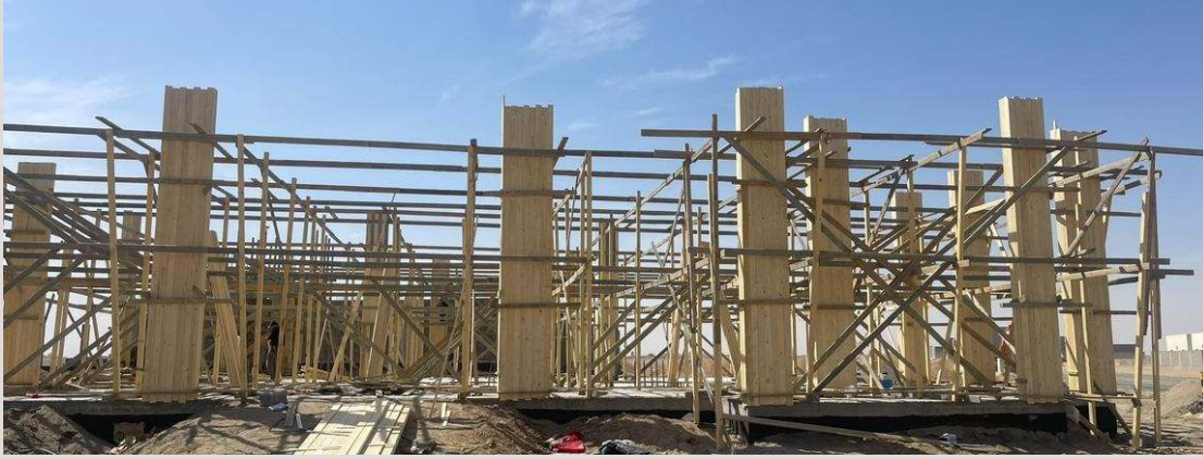
واجهة الهيكل الخرساني أثناء التنفيذ CONCRETE FRAME UNDER CONSTRUCTION
