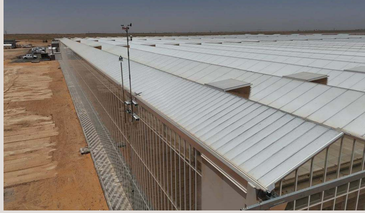
فتحات التهوية العلوية الآلية AUTOMATED ROOF VENTILATION
