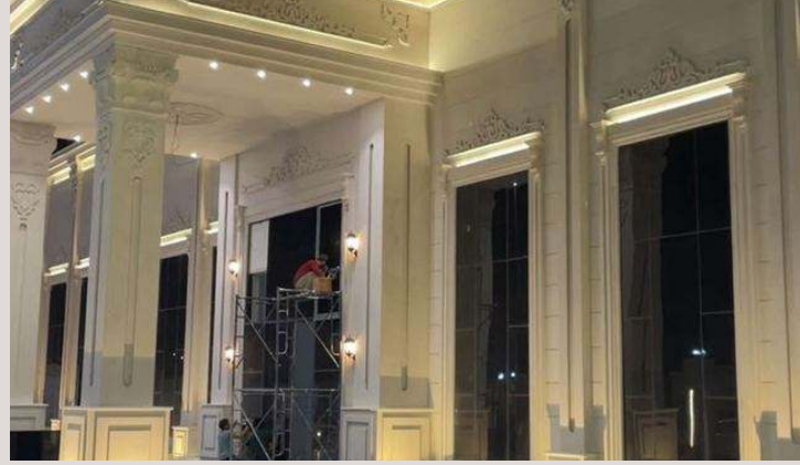
الواجهة ليلاً بإضاءة أرضية FAÇADE AT NIGHT WITH UPLIGHTING
