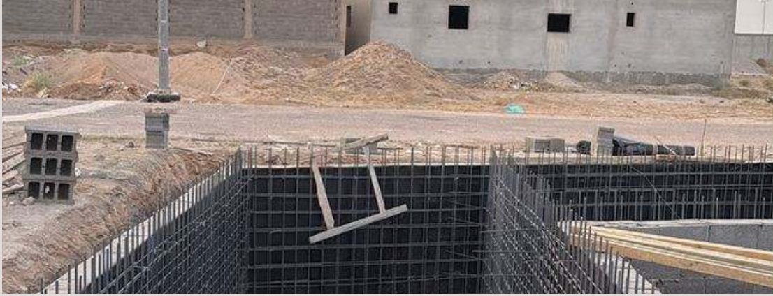
حديد تسليح خزان أرضي قبل الصب BELOW-GRADE TANK REINFORCEMENT
