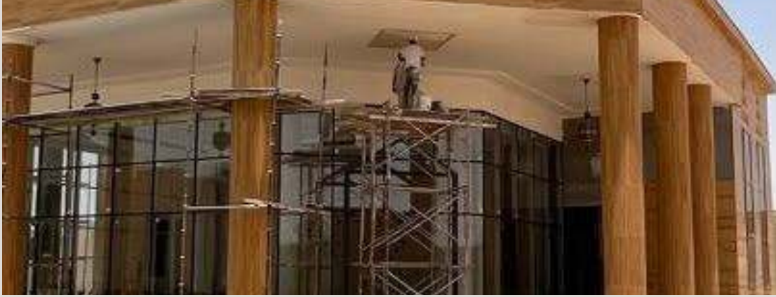
مظلة الأعمدة أثناء التنفيذ COLUMN CANOPY UNDER CONSTRUCTION
