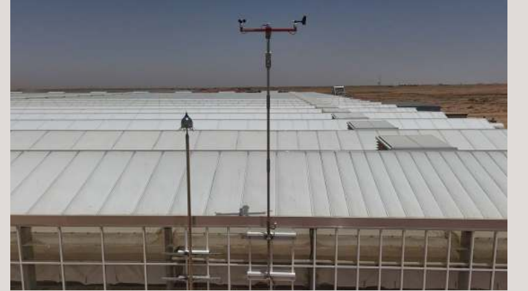
محطة الأرصاد الجوية WEATHER STATION
