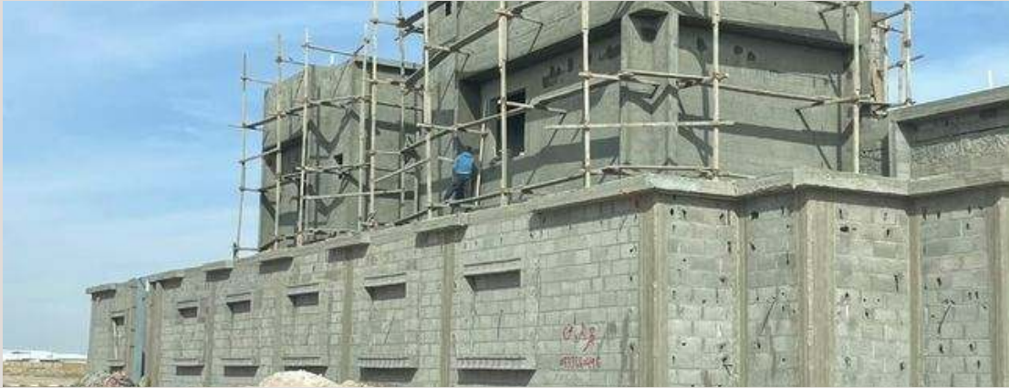
الكتلة الخرسانية بعد فك القوالب CONCRETE MASS AFTER STRIPPING
