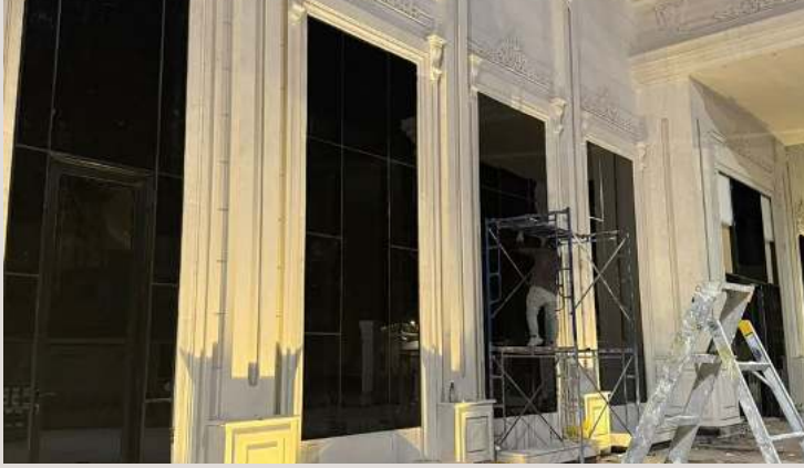
ضبط الإطارات قبل التزجيج SETTING THE FRAMES BEFORE GLAZING
