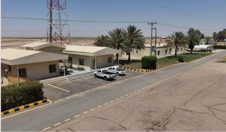
المبنى على الطريق الداخلي THE BUILDING ON THE INTERNAL ROAD ضؤل علامة تجارية مملوكة لمؤسسة المتميز الحديثة للمقاولات · 26
