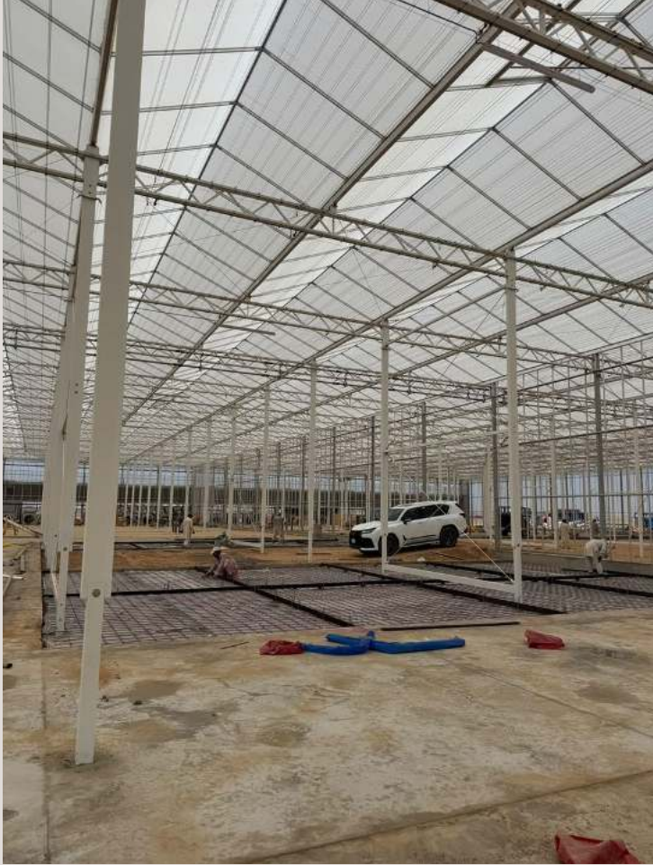
الهيكل الداخلي قبل التشغيل
