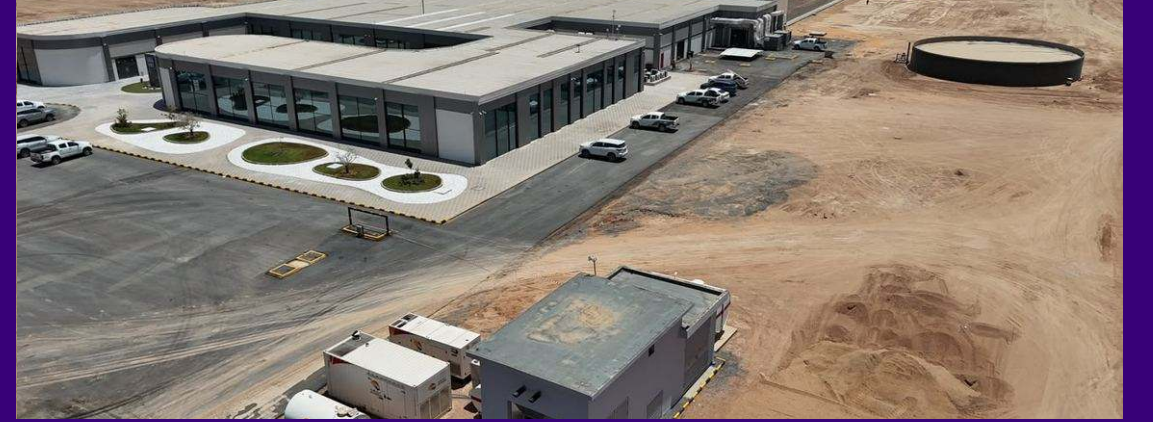
لقطة جوية — المبنى والمحطة AERIAL — BUILDING AND SUBSTATION
