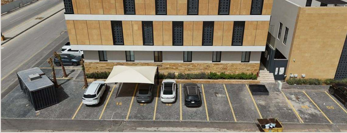
مظلة المدخل والمواقف المخططة ENTRANCE CANOPY AND MARKED PARKING
