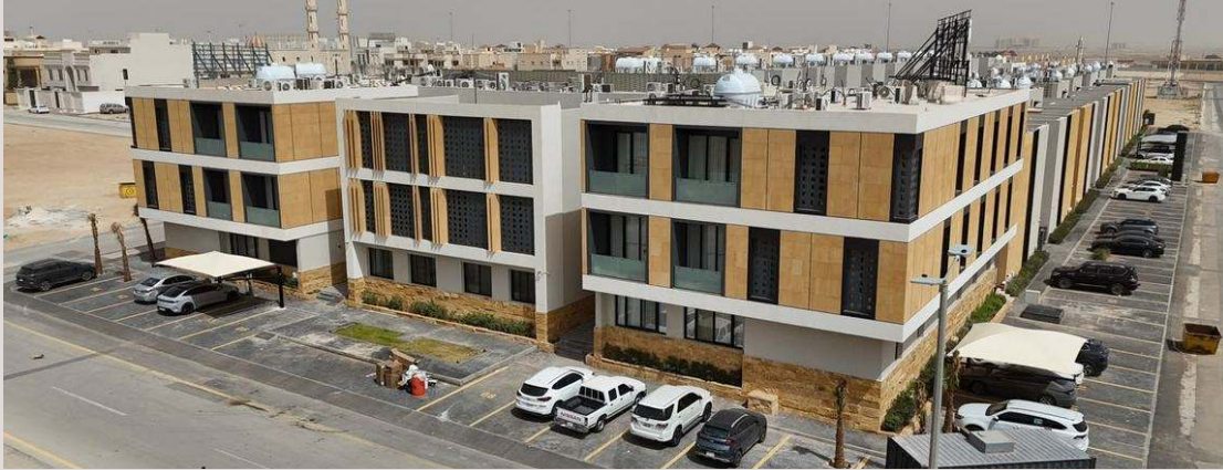
المجمع بعد التسليم THE COMPOUND AFTER HANDOVER
