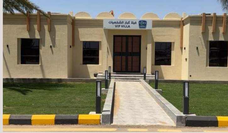
مدخل القاعة والمنحدر HALL ENTRANCE AND ACCESS RAMP
