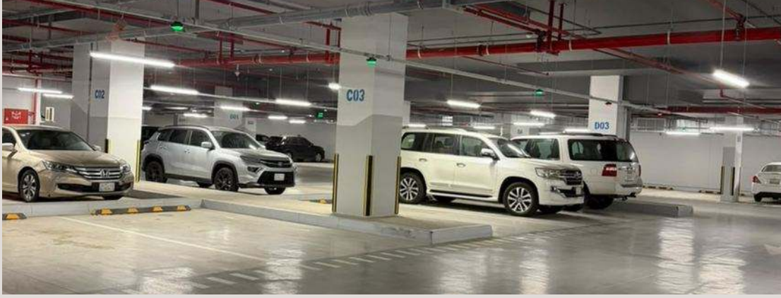
أرضية إيبوكسي بمسارات حركة المركبات EPOXY DECK — VEHICLE CIRCULATION
