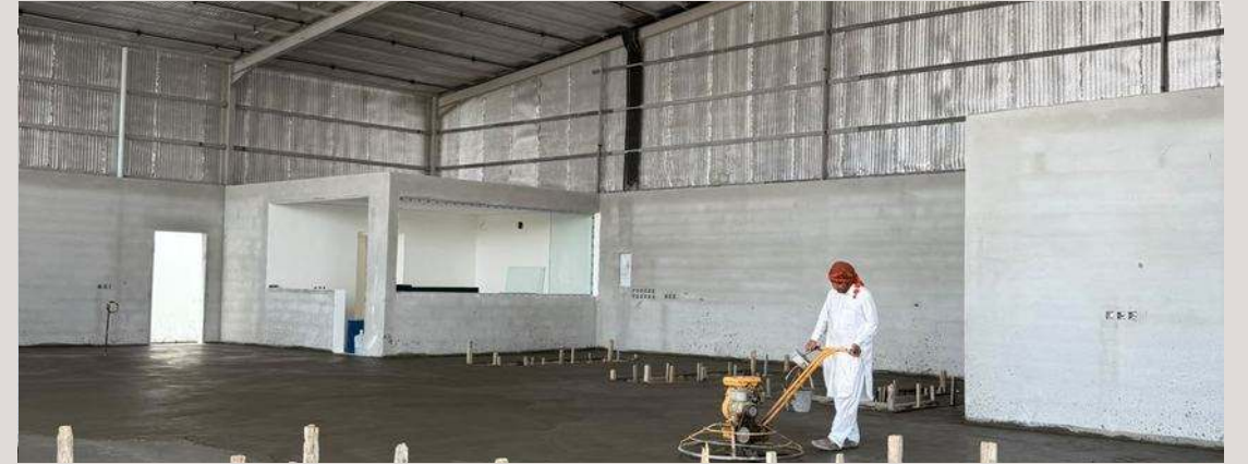
صب أرضية هنجر وتنعيمها آلياً HANGAR SLAB POUR AND POWER-FLOATING SOL is a trademark of Modern Distinguished Contracting Est.
