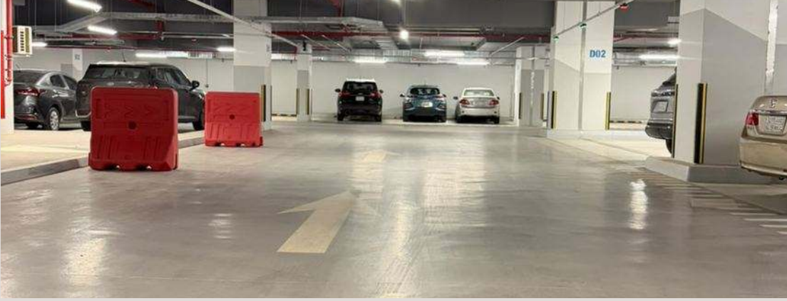
خطوط تنظيم المواقف والأسهم الإرشادية BAY MARKING AND DIRECTIONAL ARROWS
