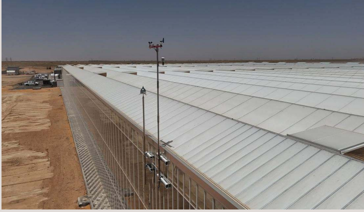
أعمدة الإنارة على المحيط PERIMETER LIGHTING COLUMNS
