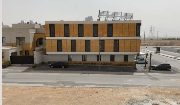
مبنى الشقق من الجهة الخلفية
