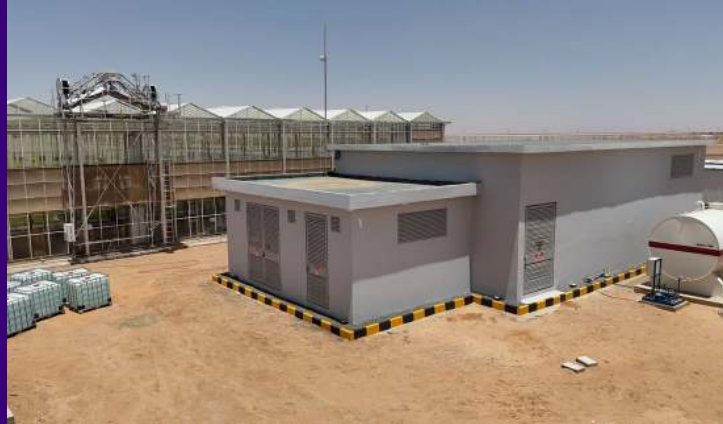
غرفة كهرباء وخزان وقود ELECTRICAL ROOM AND FUEL TANK
