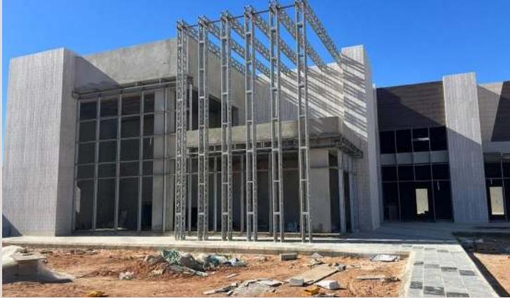
الواجهة الخرسانية والهيكل
