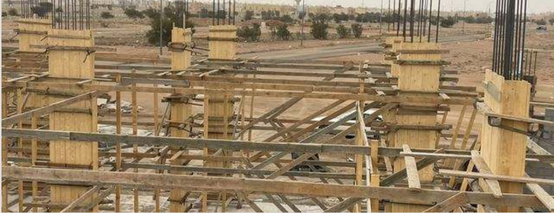
شبكة الأعمدة فوق السقف المصبوب COLUMN GRID ABOVE THE CAST SLAB
