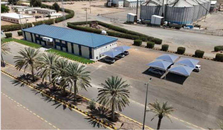
لقطة جوية — المبنى والمظلات AERIAL — BUILDING AND SHADE CANOPIES ضؤل علامة تجارية مملوكة لمؤسسة المتميز الحديثة للمقاولات · 23
